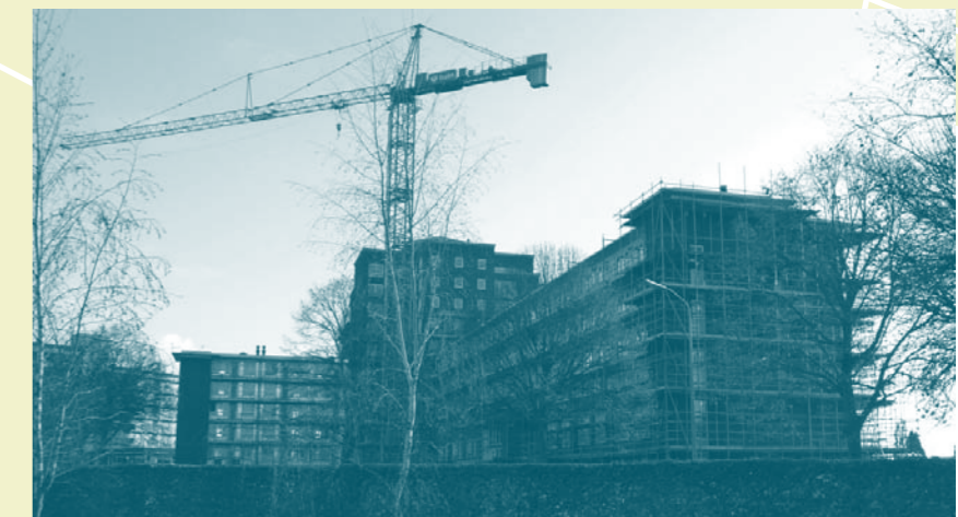
Het in aanbouw zijnde woonzorgcomplex de Zonnebaars. (Zie ook pagina 3)
